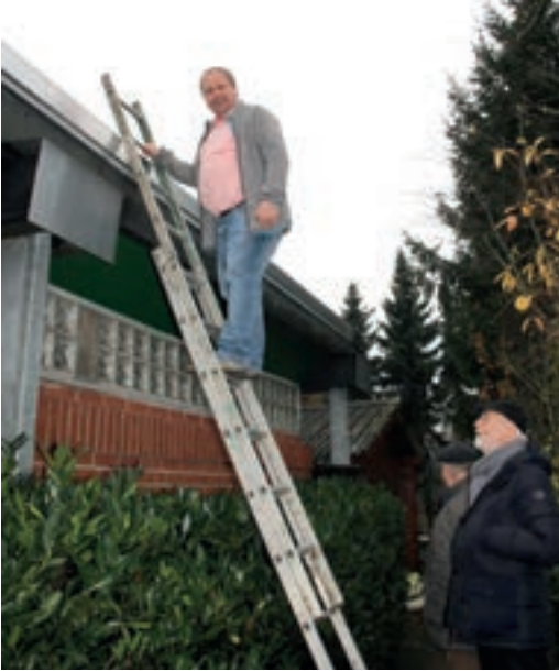
Ulf Meldau begutachtet das neue Flachdach
