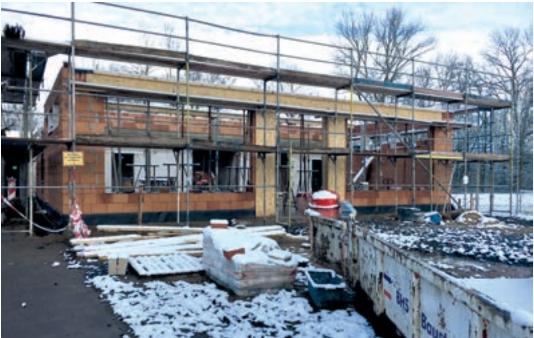
Aktueller Stand Bauprojekt Sportgelände Hohe Bünte (Rohbau)
